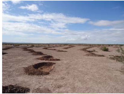
Obras de restauración (microcuencas captadoras de agua de lluvia)
