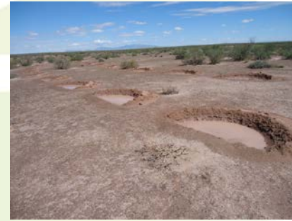
Obras de restauración (microcuencas captadoras de agua de lluvia)
